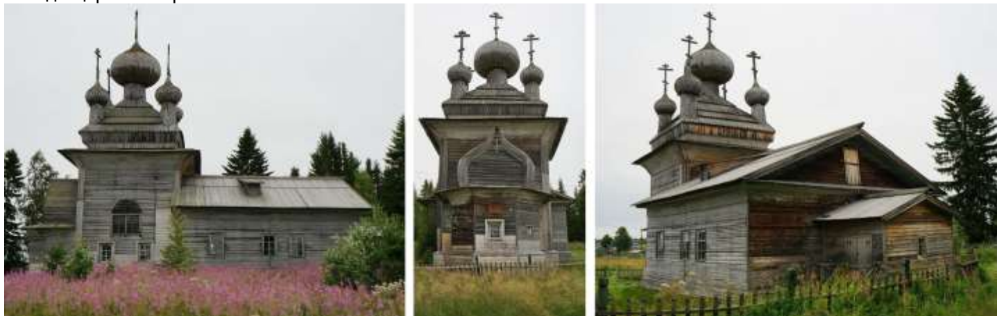
Фасады церкви Петра и Павла
